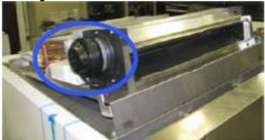
Двигатель вентилятора и клеммная коробка не должны подвергаться воздействию водяных брызг.
